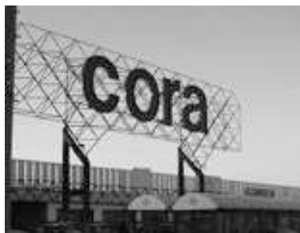
L'enseigne Cora de Mondelange avant son démontage : indépendamment de leur illégalité, de telles structures apparaissent aujourd'hui totalement anachroniques.
