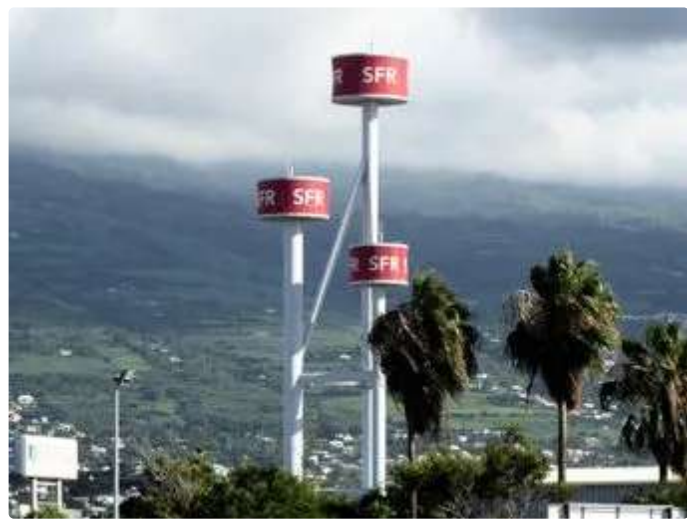
Le "Triplé olympique" pour la commune du Port sur l'île de la Réunion pour des publicités pour l'opérateur SFR au sommet d'un pylône de télécommunications. - Paysages de France
